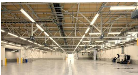
板金作業エリア
